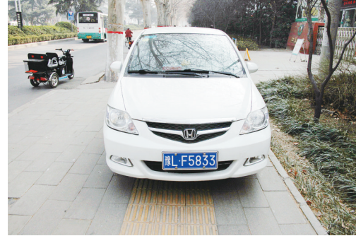
3月4日黄河路上机动车占压盲道
