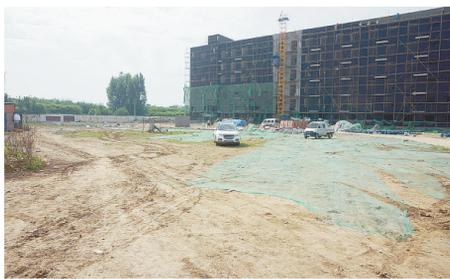
北大附中漯河校区1#教工宿舍楼施工现场黄土裸露,覆盖不彻底。
