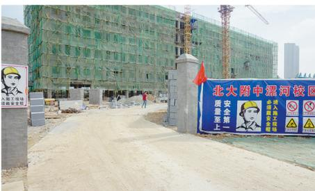
北大附中漯河校区2#教工宿舍楼施工现场无冲洗设施。
