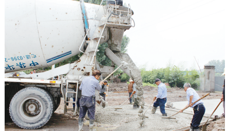
为进一步改善道路环境，近日，经济技术开发区对辖区31个路口的裸露路面进行混凝土铺设，并对破损道边、坍塌花坛等进行整治。 赵楠 摄
