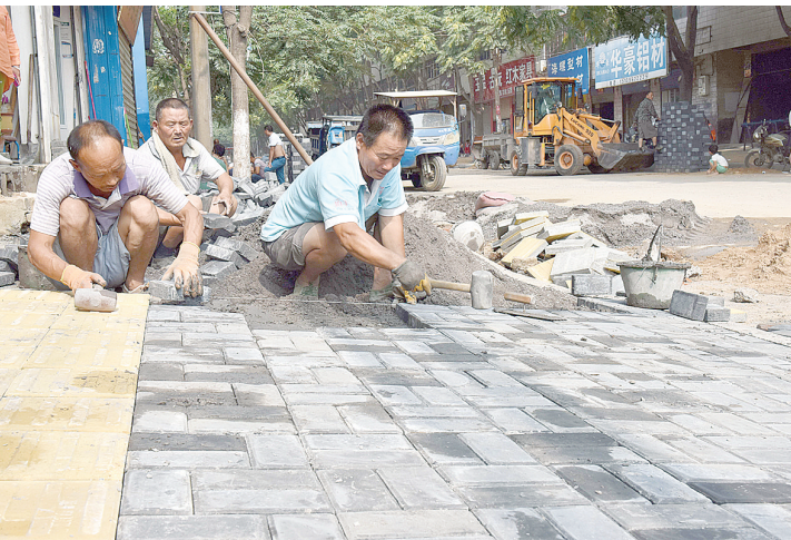
7月5日,施工人员正在整修路面。为进一步改善市民出行环境,郾城区对黄河路西段太行山路至井冈山路之间的路面、人行道进行升级改造。预计7月15日完工。
