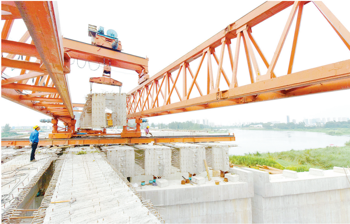
7月15日，施工人员正在架设30米T型梁。太白山路沙河桥工程北起辽河路，向南跨沙河，与西城区泾河路相接。工程全长980米，设计双向6车道，两边各有3.5米宽的人行道和4.25米宽的非机动车道。太白山路沙河桥建成后，将进一步缓解城市交通压力，促进郾城区与西城区的经济发展。预计10月1日前后建成通车。 本报记者 王晓东 摄
