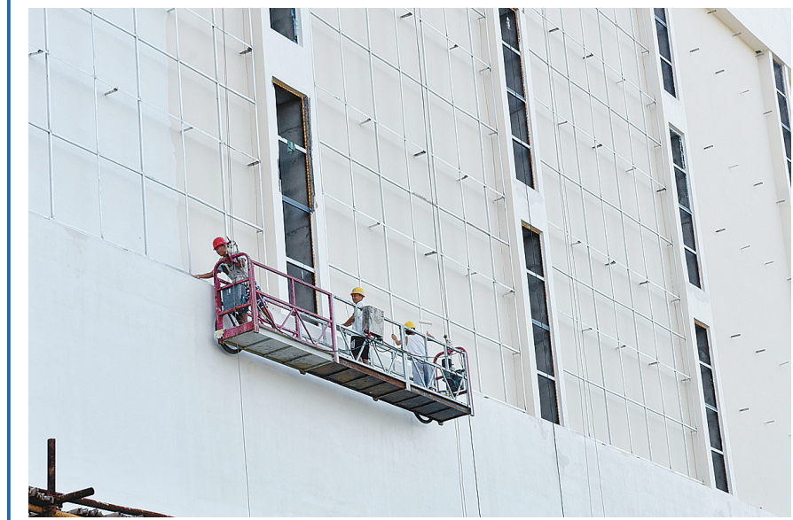
7月27日，漯河陆洲小商品城建设有限公司义乌国际商贸城建设项目正在进行外墙装饰。
