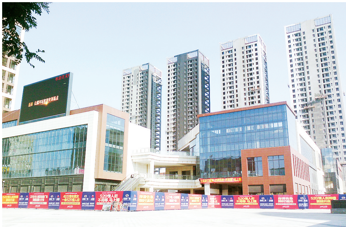
漯河昌建时代广场项目商业部分六大区域全部建成。
