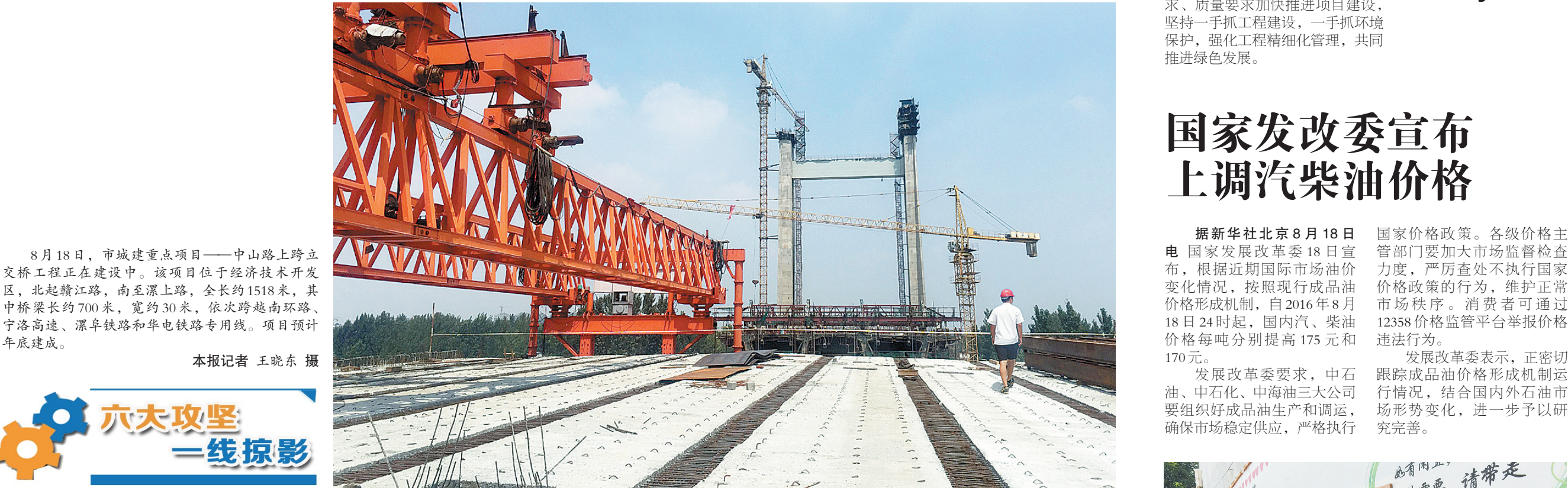
8月18日，市城建重点项目——中山路上跨立交桥工程正在建设中。该项目位于经济技术开发区，北起赣江路，南至漯上路，全长约1518米，其中桥梁长约700米，宽约30米，依次跨越南环路、宁洛高速、漯阜铁路和华电铁路专用线。项目预计年底建成。 本报记者 王晓东 摄
