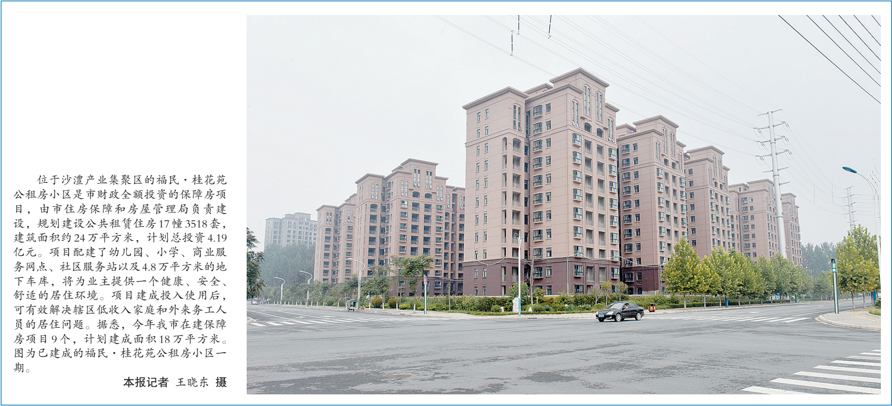
位于沙湾产业集聚区的福民·桂花苑公租房小区是市财政全额投资的保障房项目，由市住房保障和房屋管理局负责建设，规划建设公共租赁住房17幢3518套，建筑面积约24万平方米，计划总投资4.19亿元。项目配建了幼儿园、小学、商业服务网点、社区服务站以及4.8万平方米的地下车库，将为业主提供一个健康、安全、舒适的居住环境。项目建成投入使用后，可有效解决辖区低收入家庭和外来务工人员居住问题。据悉，今年我市在建保障房项目9个，计划建成面积18万平方米。图为已建成的福民·桂花苑公租房小区一期。 本报记者 王晓东 摄
