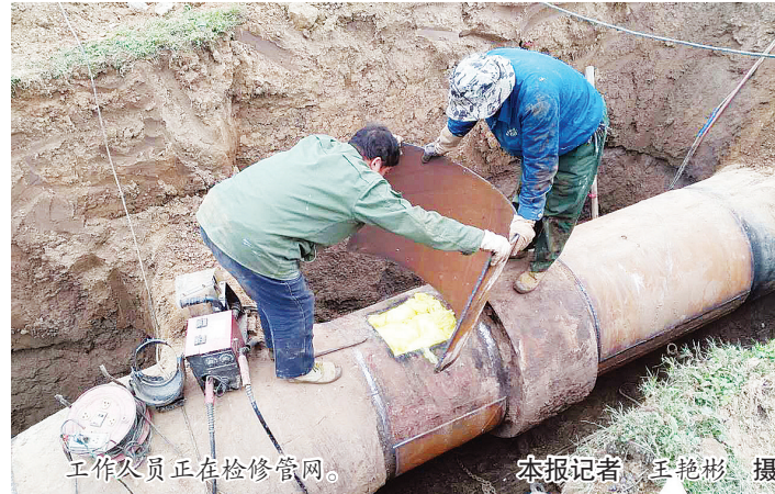
工作人员正在检修管网。 本报记者 王艳彬 摄
