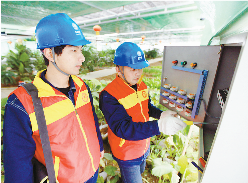
2月21日,舞阳县供电公司派出一支电力服务小分队,到该县重点蔬菜示范园区排查安全隐患、检修电路,确保大棚内温控设施、喷灌设施用电安全。 李 寅 张晓璐 摄
