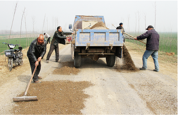
3月5日，召陵区河道修防段工人在沙河河堤邓襄段维护河堤路面。为确保河堤沿线道路安全畅通，修防段工人加大对道路、堤防的巡查力度，及时修补破损路面。 ■本报记者 范子恒 摄
