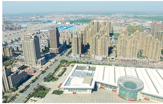
高档住宅小区
