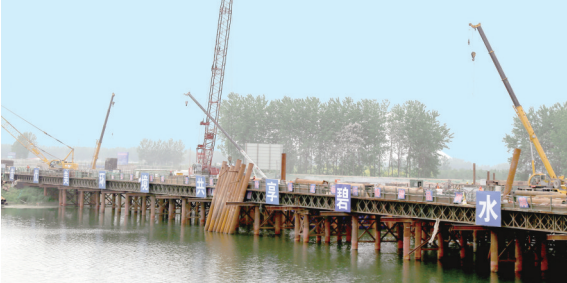
正在建设的牡丹江路沙河大桥
