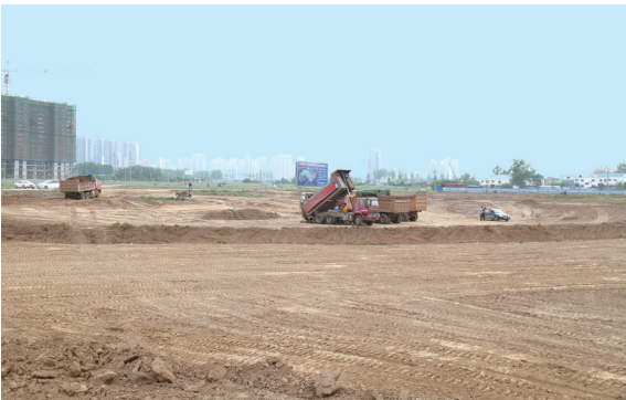
东湖建设工程施工现场
