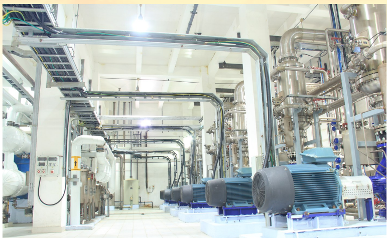
▲美国嘉吉漯河项目生产车间
