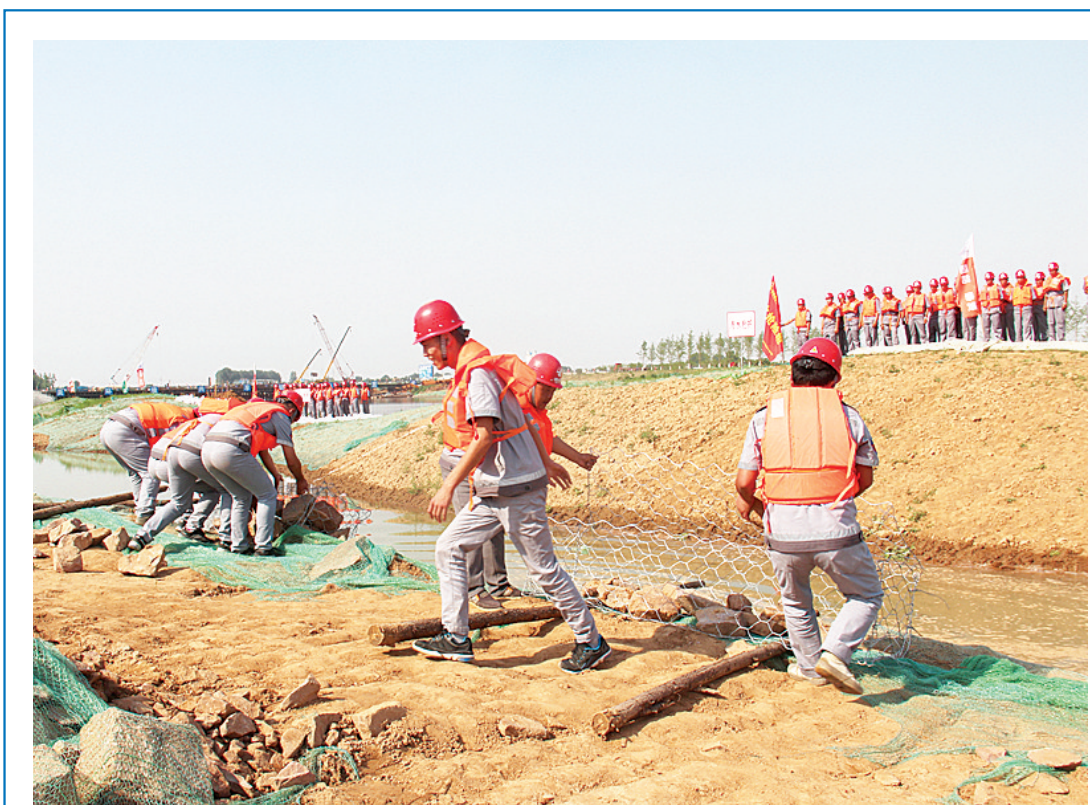
5月25日下午,市城乡一体化示范区沙河沿岸综合整治PPP项目2017年防汛抢险演练举行,依次进行了人工打桩、塌岸抢险、渗水抢险、漫溢抢险、水上救护五个项目。
