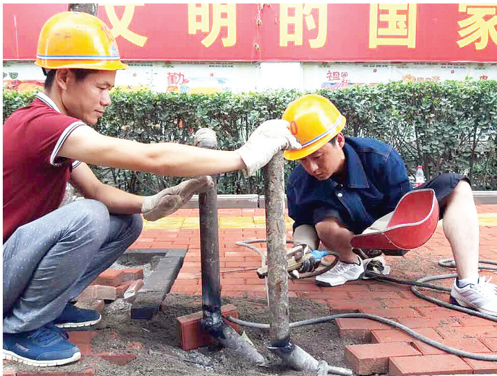
工人正在加高排潮管。
