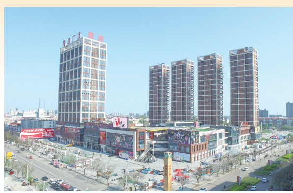
全市最大的城市综合体——昌建广场。
