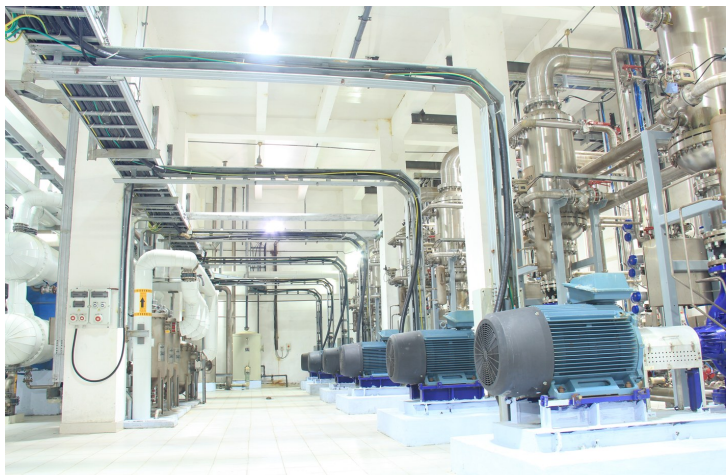
美国嘉吉漯河项目生产车间
