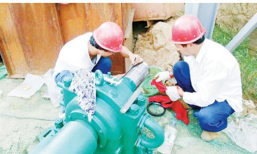
8月21日, 淞江产业集聚区热电联产项目建筑工地, 工作人员正在安装锅炉辅助设备的引风机。漯河恒瑞热电有限公司加快淞江产业集聚区热电联产项目建设, 力争早日实现投产运行, 以满足郾城区用热需求。 本报记者 王艳彬 摄
