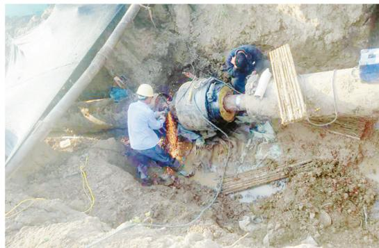
8月24日，天阳供热公司工作人员在立达工业园内安装焊接热力管道。经济技术开发区立达工业园DN200次主管网项目全长约600米，主要解决立达工业园内多家企业的用热需求。目前该管网已基本完成，即将具备供热条件。 本报记者 王艳彬 摄
