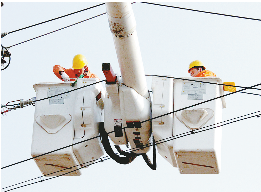
11月16日,漯河供电公司工作人员正在对输电线路进行检修维护。为应对冬季用电高峰,漯河供电公司提前制订电网迎峰度冬预案,对部分老旧设备进行更新升级,消除各类安全隐患,提高辖区电网供电安全水平。 本报记者 李慧宇 摄
