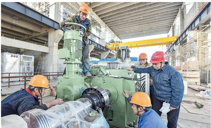
郟城区淞江产业集聚区集中供热项目由漯河市恒瑞热电有限公司投资建设，预计在今年年底建成投产。建成后，年发电量为2.26亿千瓦时，供电量为1.81亿千瓦时，供热量169.3万吨，可取代集聚区内燃煤锅炉40台，减少烟尘排放量3.82万吨，减少灰渣排放量1.13万吨。图为11月28日技术人员正在调整汽轮发电机组。
