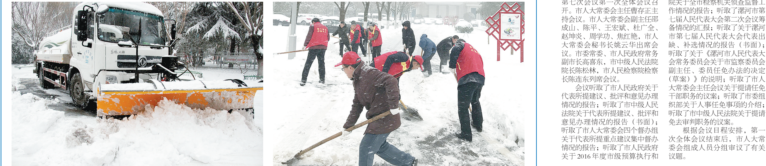
1月4日，市环卫处除雪机械正在嵩山路除雪。 本报记者 范子恒 摄 1月4日，市政府办公室组织党员志愿者清扫道路积雪。 本报记者 胡鸿丽 通讯员 陶元 摄
