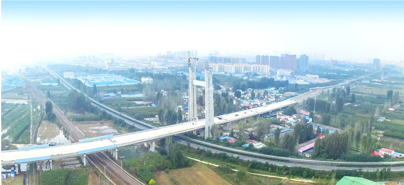
建设中的中山路立交桥
