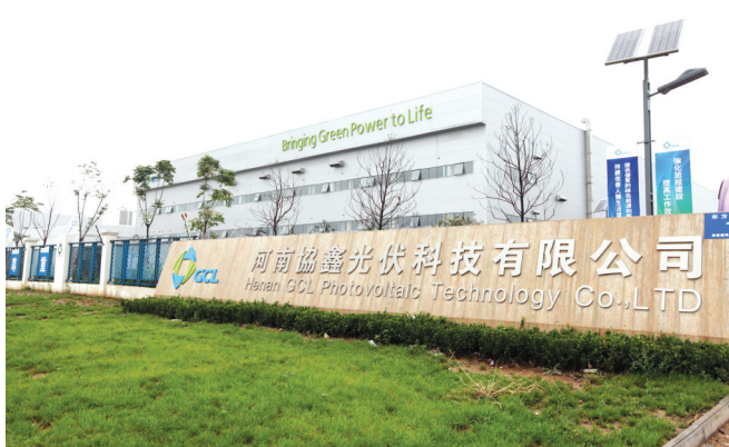
河南协鑫光伏科技有限公司
