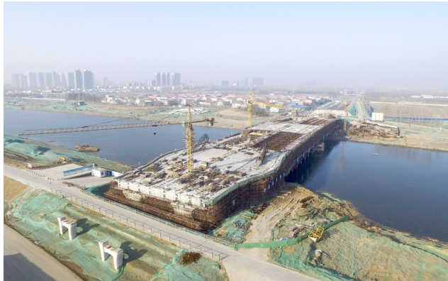
牡丹江路沙河大桥项目
