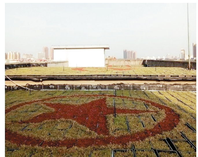
为助力环保攻坚,改善我市城市生态环境,团市委申请到河南省青年创业就业基金会180万元资金支持,并于今年3月初开始对我市部分机关的办公楼楼顶进行绿化。图为近日已绿化完成的市委老楼楼顶和市政府老楼楼顶。
