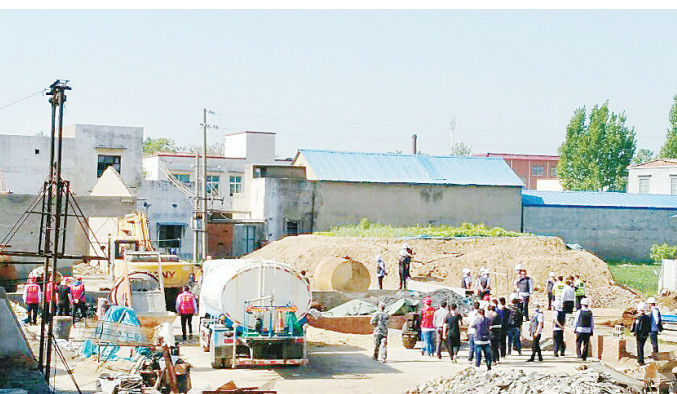
4月19日,在市环保监察队的指导下,郾城区组织政法、环保、城管、建设、交通、公安、商务、国土、龙城镇等单位,对龙城镇4家环境违法、土地违法企业现场执法。本次行动共出动260余人,车辆100余辆、大型钩机2台、洒水车1台,对4家企业的设备、生产厂房实施拆除,有效打击了全区土地违法、环境违法行为。 本报记者 姚肖 摄
