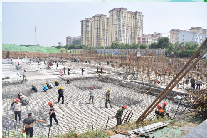
漯河高中东校区(召陵区)建设正在紧张有序进行。
