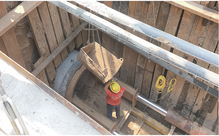
工人正在进行雨污分流项目顶管施工。 本报记者 杨会枝 摄
