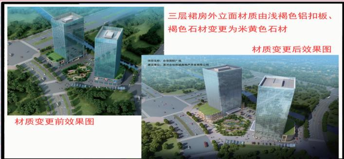
三层裙房外立面材质由浅灰色铝扣板、褐色石材变更为米黄色石材
