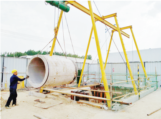
施工人员进行下管作业。
