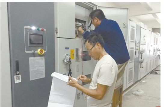
目前,由漯河天阳供热公司投建的恒瑞热电公司“淞江产业集聚区热电联产项目”进入初步调试阶段。图为7月23日,工作人员在进行高压变频器调试。
