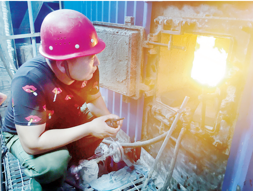
8月9日，工作人员在对漯河恒瑞热电有限公司“淞江产业聚集区热电联产项目”的2#锅炉进行烘炉。由于新砌筑的锅炉墙及高温烟道可能含有水分，为确保锅炉运行的安全性、经济性，必须烘炉合格后，项目才能投入运行。 本报记者 王艳彬 摄
