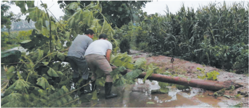
抢修人员正在搬开挡住道路的树木。
