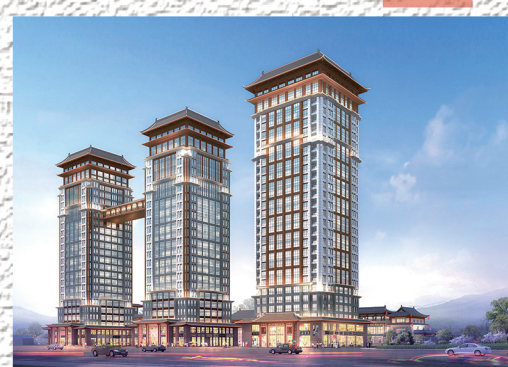
河上街广场 (建设中)
