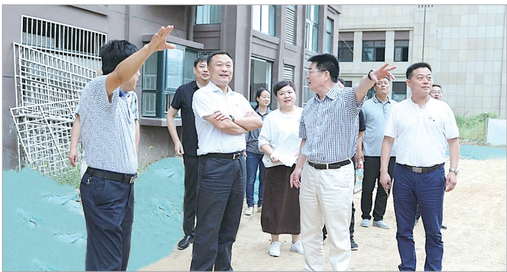
市住建委领导带队察看保障性住房建设情况。
