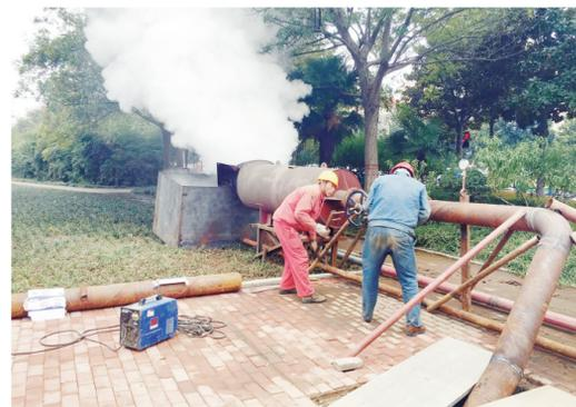
11月10日,天阳供热公司工作人员在清除黄山路热力管道内的杂质,检验管道安装质量。据了解,该管网已具备供暖条件。
