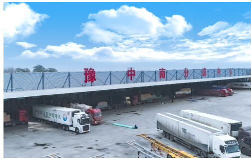
伊利乳业豫中南分拨中心项目
