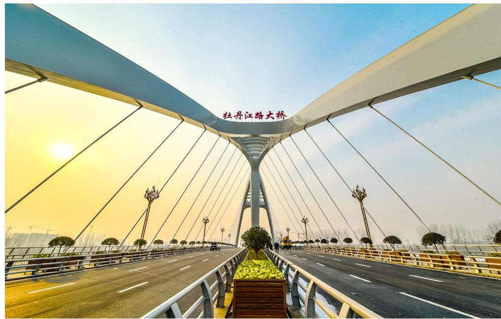
竣工通车的牡丹江路沙河大桥
