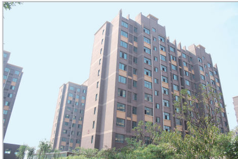
民心工程——注张村安置房。
