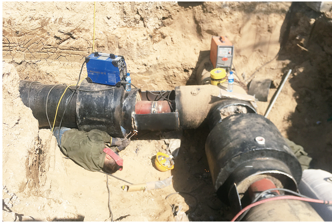
近期，漯河天阳供热公司对全线热力管网和阀门井、排潮管等附属设备进行安全普查，并对存在隐患的部位及时进行检测、检修。图为3月18日，热力工人正在对经济技术开发区创新路一处出现非正常排潮现象的排潮管进行维修。
