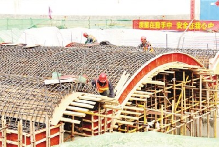
幸福渠城区段主体工程正在施工。
