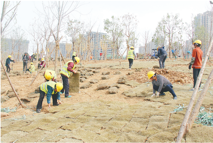
3月19日，在沙澧河二期工程太白山路沙河桥以西沙河北岸，工人们正在抓紧铺设地被。
