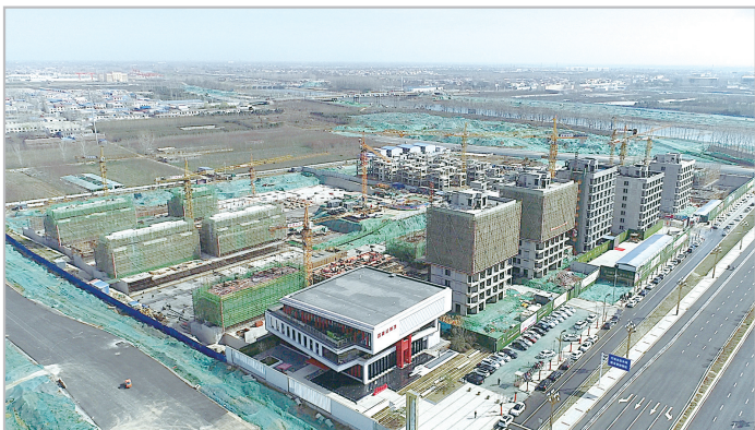
建设中的昌建总部港项目
