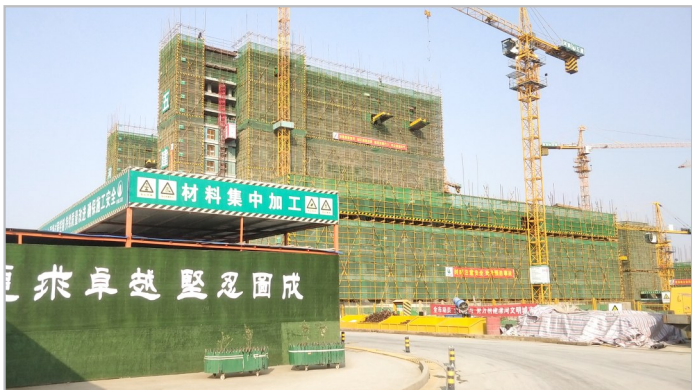
建设中的建业桂园项目
