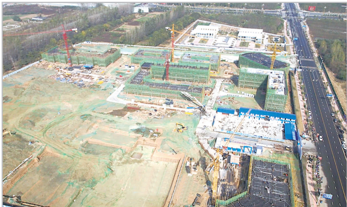
建设中的西湖学校项目
