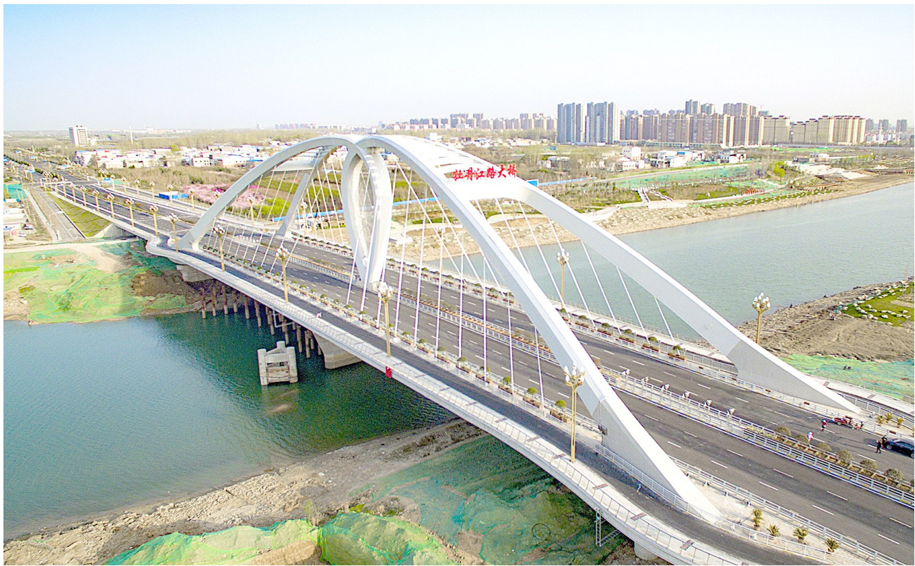
竣工通车的牡丹江路沙河大桥
