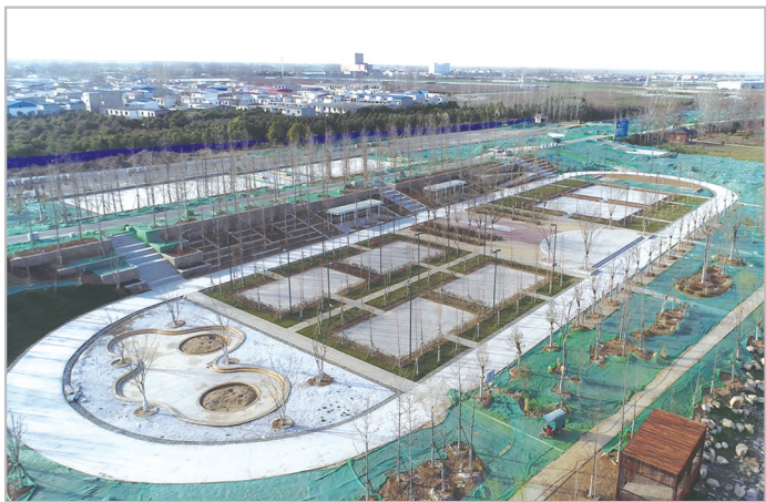
沙河沿岸综合整治项目
