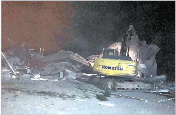
舞阳县吴城镇党委、政府发扬连续作战作风,连夜拆除违法占地建筑。
