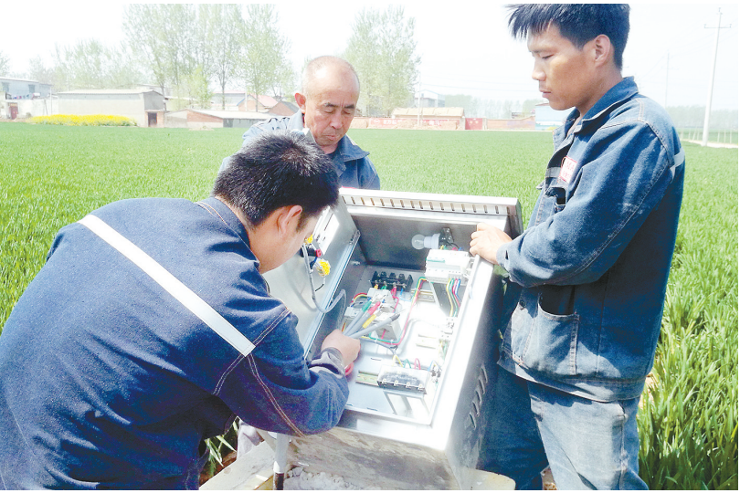
4月8日，在郾城区商桥镇沟张村麦田里，电力工人正在为新建的配电台区接线。该台区建好后，将为12眼机井提供电能，覆盖灌溉面积300余亩。 本报记者 范子恒 摄
