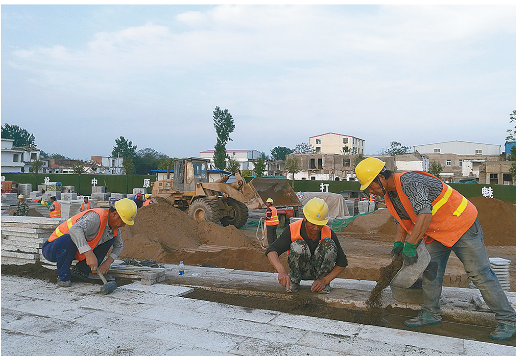
4月24日，沙湾河二期市城乡一体化示范区校正园，工人们正在紧张施工，预计“五一”开园。据了解，校正园内的设施包括中国共产党入党誓词、党的辉煌印记、党的光辉历程、红色石林、伟人寄语、模范石六大主题内容。 本报记者 张辰阳 摄
