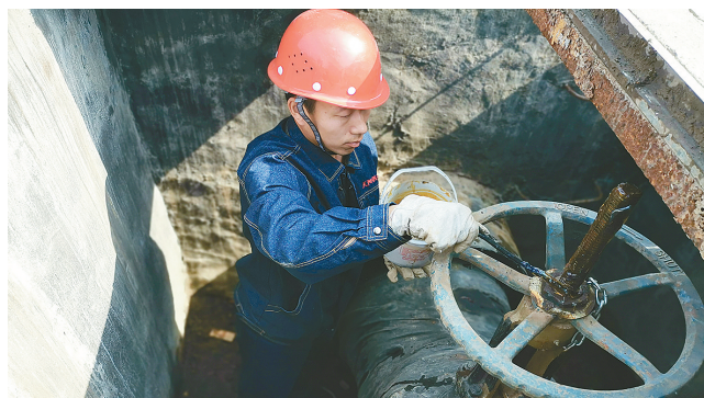
5月15日,在黄山路,供热工作人员在热力井内保养阀门。汛期到来前,漯河天阳供热公司将完成供热主管网沿线300座热力井、400余个阀门的清理、养护工作,切实保障区域供热设施安全运行。 本报记者 王艳彬 摄
