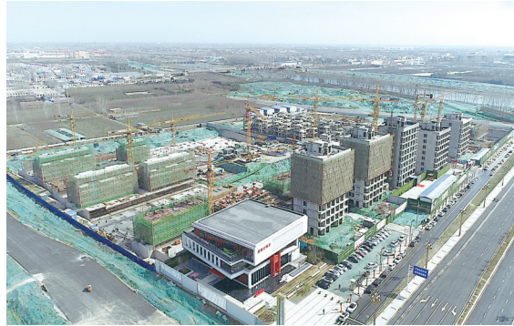
建设中的昌建总部港项目
