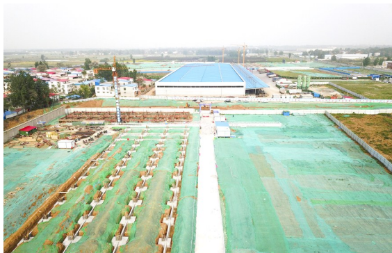
建设中的千易盛体育文化项目
