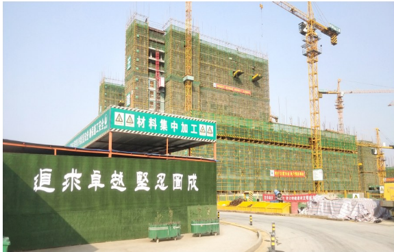
建设中的建业桂园项目
