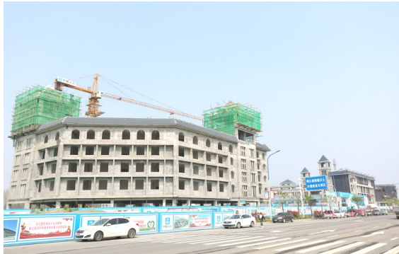
建设中的西湖学校项目
