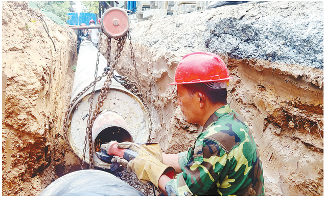
6月25日，经济技术开发区庐山路，热力工人在安装、焊接热力管道。庐山路（锦江路—渭河路段）热力管网工程全长486米，现已开挖管沟100米、安装管道50米。 本报记者 王艳彬 摄
