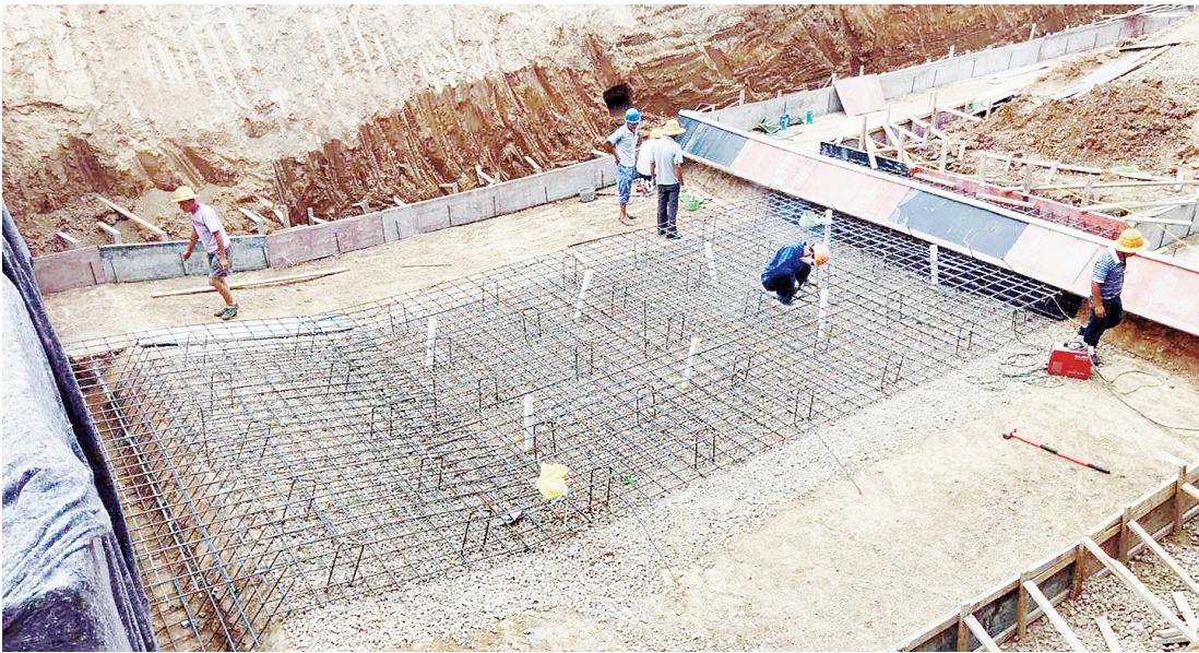
6月25日，幸福渠（崂山路—舟山路段）工地，工人们正在2号钢坝消力池绑扎钢筋。目前，幸福渠（市区段）生态水系连通工程正在加紧施工。 本报记者 张晨阳 摄
